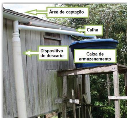
Figura 1. Sistema de captação da água da chuva instalado em uma residência da comunidade Julião – RDS Tupé.
